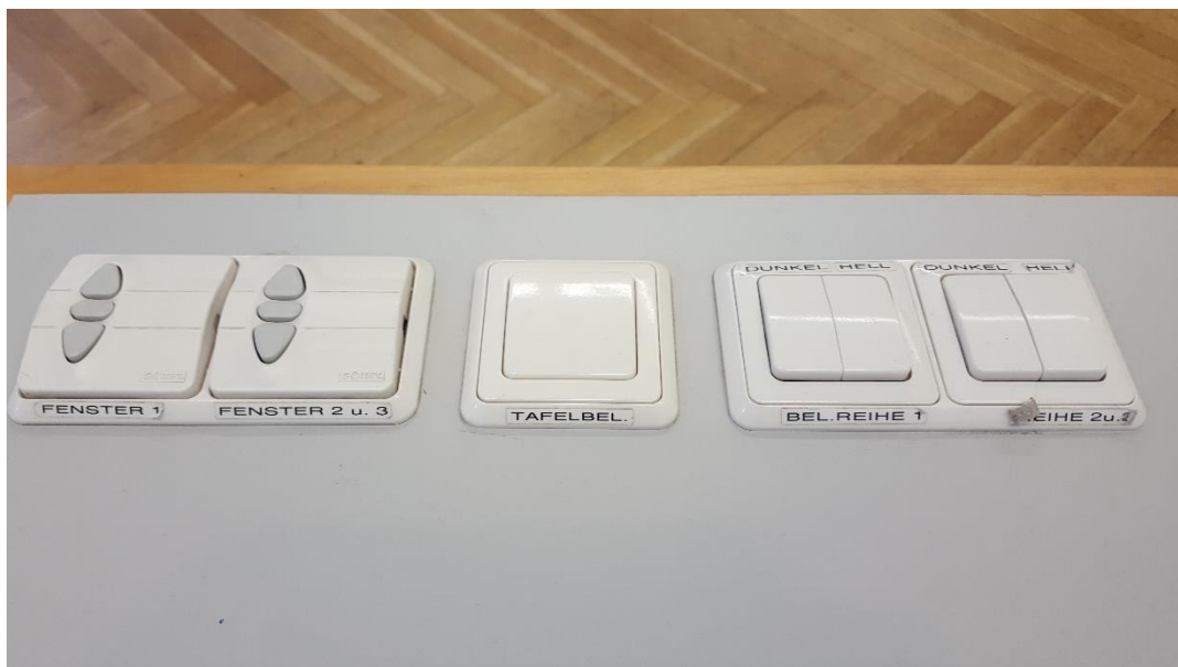
Steuerung von Licht und Verdunklung über Kippschalter auf dem Pult
