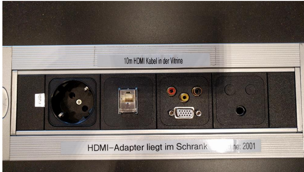
Anschluss Konferenztisch vorne links für VGA oder mit Adapter auf HDMI
