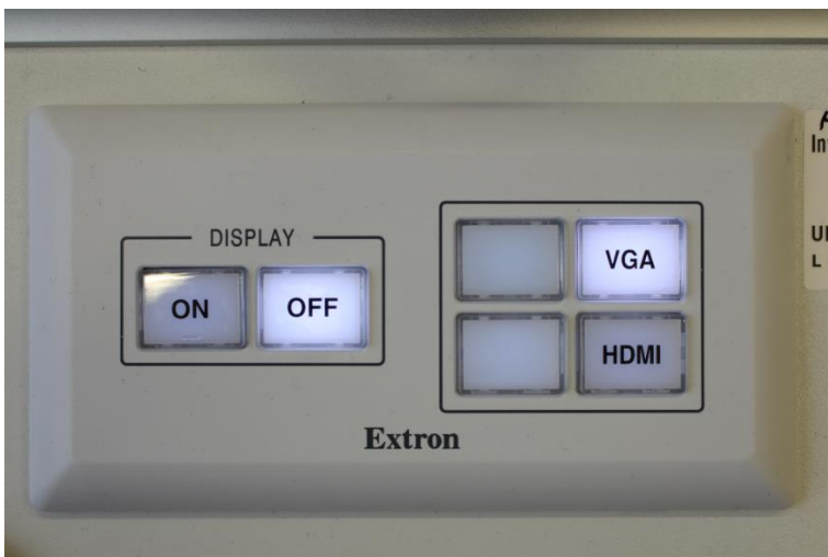
Tastenbedienfeld Hauptprojektor zur technischen Steuerung
