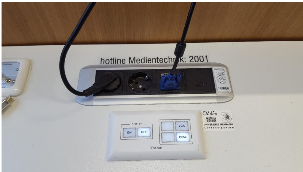
Vorhandene Anschlüsse Hauptprojektor (HDMI Kabel und Audiokabel bei Bedarf eigene verwenden)
