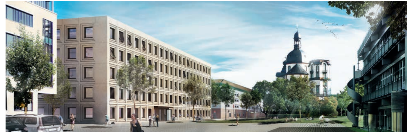
Forschungs- und Lehrgebäude in B6 | Bild: wulf architekten
