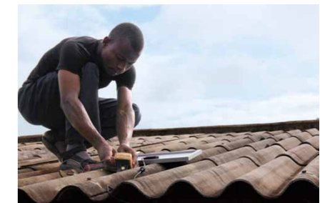
Hier werden gerade Solaranlagen auf das Dach einer Krankenstation montiert
